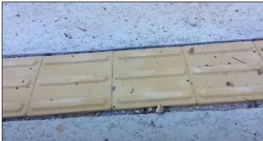
Figura 53: Assentamento piso tátil de concreto
