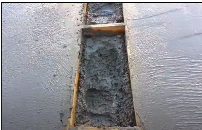
Figura 52: Assentamento piso tátil de concreto
